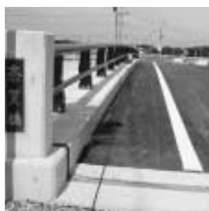
▲開通になった奈賀橋
