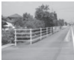
▲設置された防護柵
