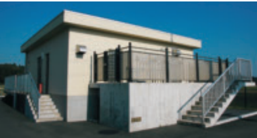
農業集落排水処理場
