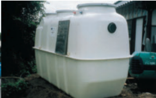
合併処理浄化槽
