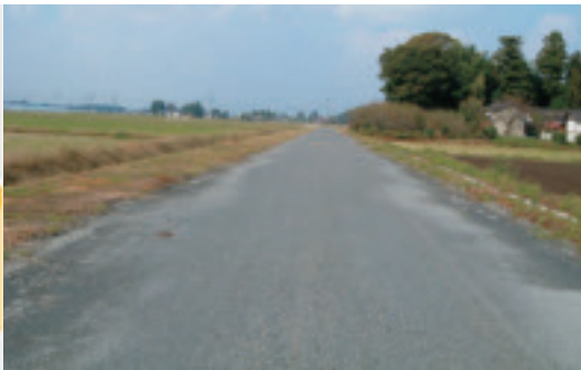
町単独道路新設改良費(市の堀線道路改良)
