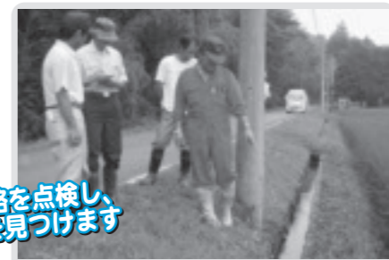
水路施設の点検(西高橋)
