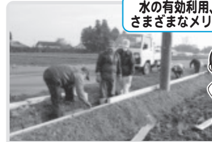
水路のかさ上げ(西高橋)
