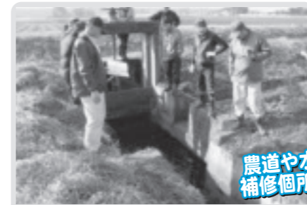
水路施設の点検(下高根沢北部)
