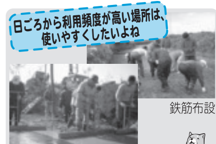
水路敷コンクリート打設(東高橋)
