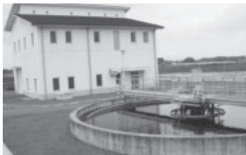
▲芳賀町水処理センター
