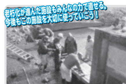
水門木板の加工取り付け(稲毛田)
