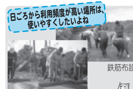
水路敷コンクリート打設(東高橋)
