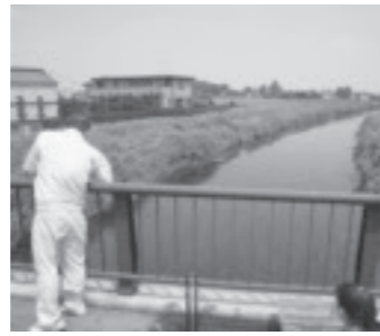
▲五行川奈賀橋
