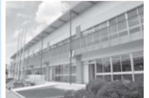
▲教室棟の外観
