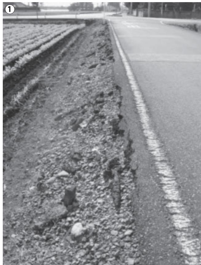
①アスファルトが崩れて砂利が農地に流れ出しています。
