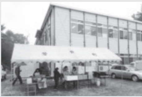
▶女川町仮設庁舎
