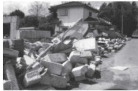
撤去前の壊れた大谷石の塀と石蔵(稲毛田地内)
