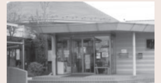
上高根沢ふれあいセンター (高根沢町図書館上高根沢分館)
