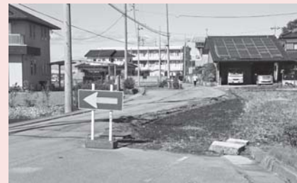
▲町道改良工事(町民会館付近)
