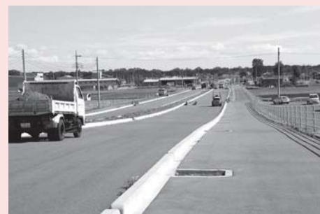
▲バイパス工事（上延生付近）
