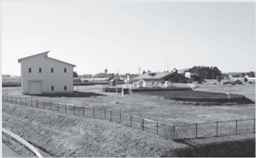
▲公共下水道処理施設 (芳賀町水処理センター)
