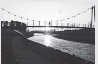
▲五行川 吊り橋付近
