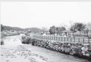
▲西水沼親水公園付近
