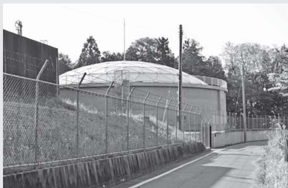
▲芳志戸配水池
