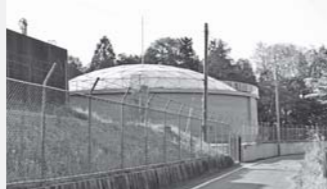
▲芳志戸配水池
