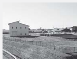
▲公共下水道処理施設 (芳賀町水処理センター)
