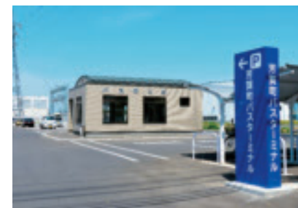
▲芳賀町バスターミナル(芳賀町工業団地管理センター付近)
