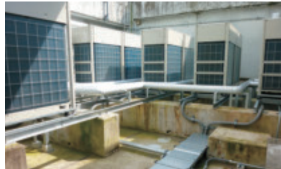
▲役場空調設備改修 施工管理業務286万円 改修工事1億4,411万円
