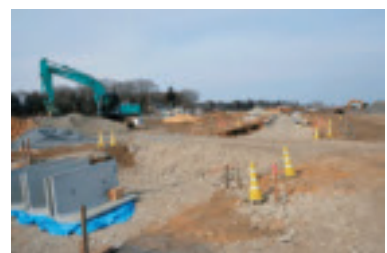
〈造成工事の進む祖陽が丘〉
