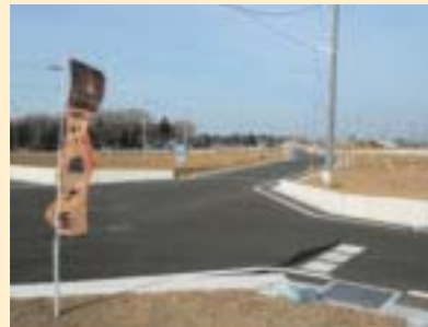
▲祖陽が丘住宅団地の造成・分譲開始
