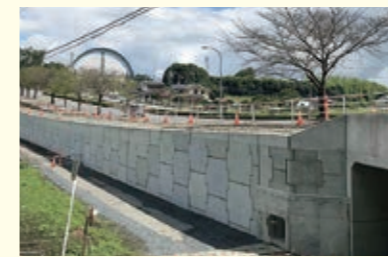
▲ LRT工事の様子(下高根沢地内)
