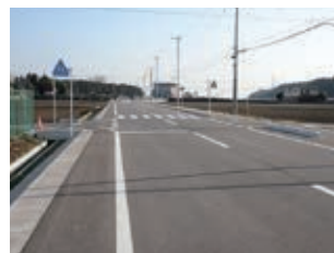
▲工事が完了した三日市・芳賀第二工業団地線
