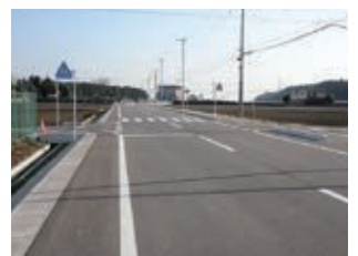
▲工事が完了した三日市・芳賀第二工業団地線
