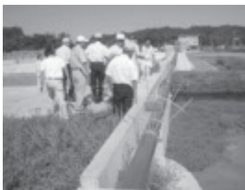
下高根沢野元橋(下水道)
