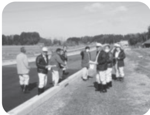
公共下水道事業調査(芳賀バイパス)
