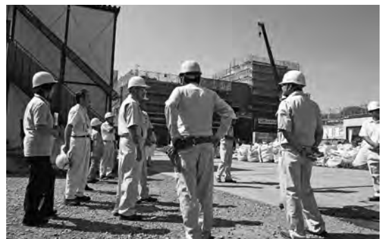
< 広域ゴミ処理施設 >
