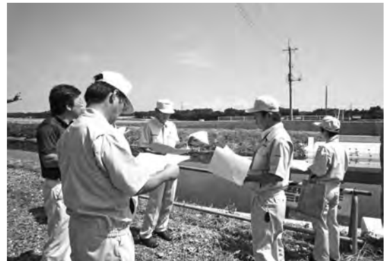
<金井橋下部工>
