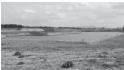
▲工事中の遊水地
