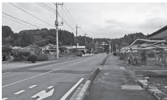
▲町道 大橋・堂ノ前線（給部地内）
