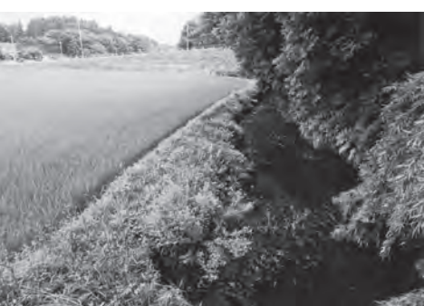
▲未整備の土水路
