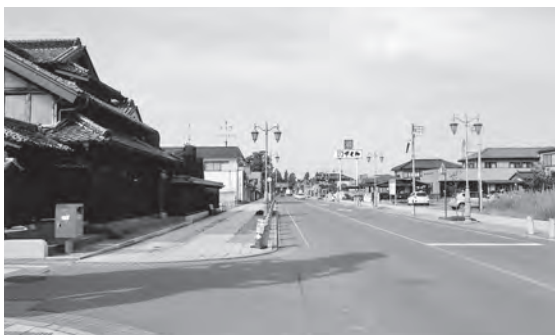
▲電線を地中化した上三川町の街並み
