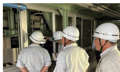
▲排水処理センター
