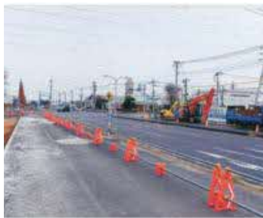
▲管理センター前停留場トランジットセンター掘削
