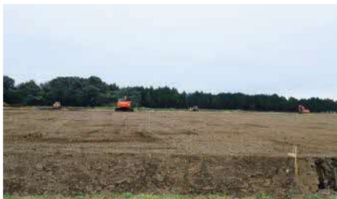
▲急ピッチで造成工事が進む芳賀第2工業団地
