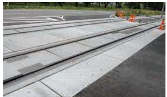
▲樹脂固定軌道の整備イメージ(清原工業団地内)
