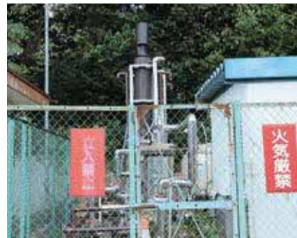
▲ポンプ交換を行う第1号源泉
