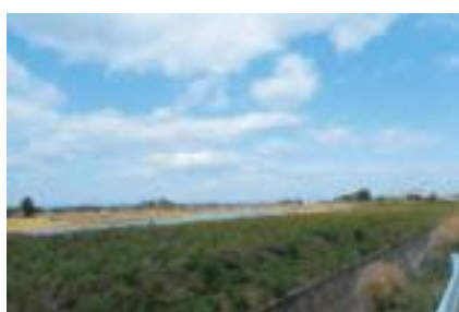
▲工事が進む芳賀遊水地予定地
