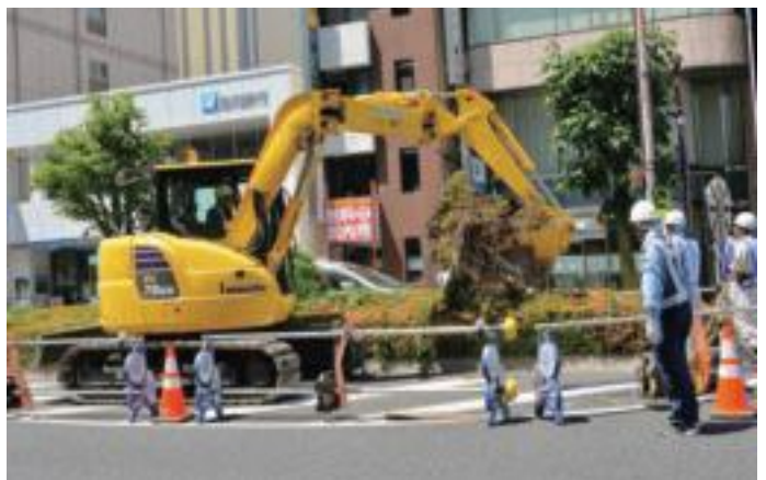
▲LRT事業着工の様子(宇都宮駅東口)
