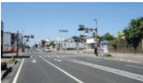
▲無電柱化された真岡市の街並み
