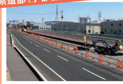
地盤改良工事がほぼ完了し、間もなく軌道(レール)を敷く工事が始まります。
