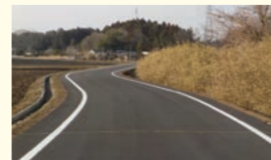
▲整備された町道打越新田線
