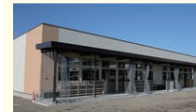
▲新築された芳賀東小学校児童保育施設
