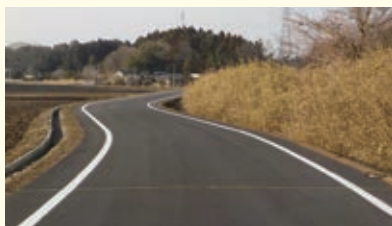
▲整備された町道打越新田線
