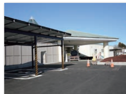
▲段差が解消された駐車スペース
