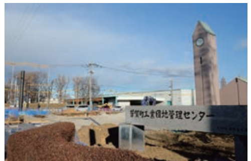
▲工事が進むトランジットセンター
