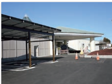
▲段差が解消された駐車スペース
