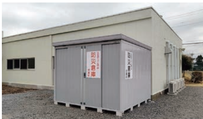
▲防災倉庫を設置
