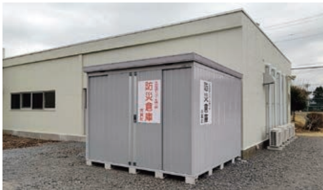
▲防災倉庫を設置
