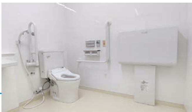
▲多目的トイレを新設(おむつ交換台あり)
