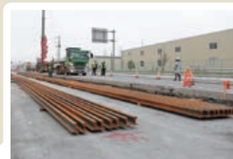
町内にレールが納入された時の様子(芳賀台停留場付近)
