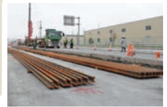
町内にレールが納入された時の様子(芳賀台停留場付近)
