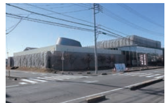
▲総合情報館外壁改修工事
