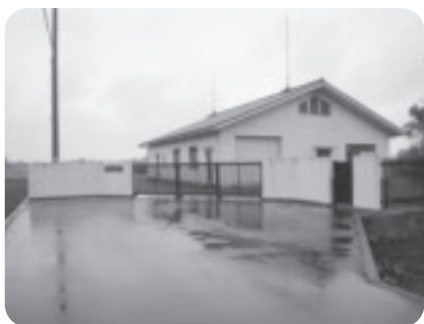
改修予定の東水沼集落排水処理センター
