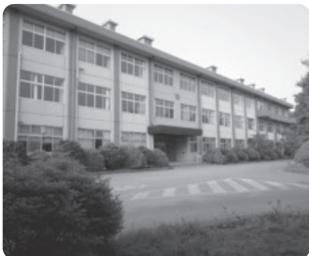
解体が予定されている旧芳賀高校
