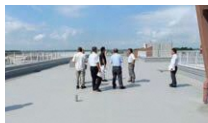
▲修繕後の芳賀東小学校屋上
