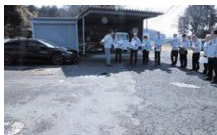
▲防火水槽撤去
