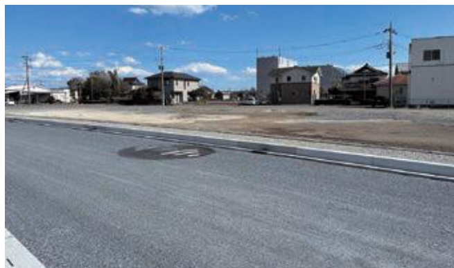
▲町民会館北側の住宅地整備
