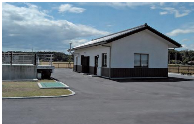
▲農業集落排水処理施設
